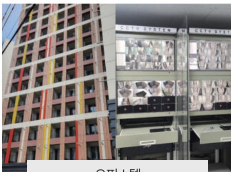
오피스텔 CCTV 납품 및 설치 사진
