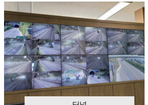
터널 CCTV 납품 및 교체 사진
