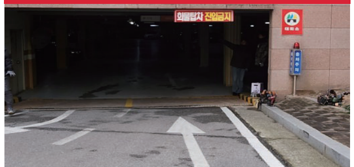
아파트 및 지하주차장
