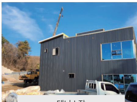
테니스장 전기 및 통신공사 사진
